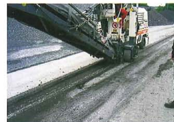
Bild 6: Fräsen der Asphaltdeckschicht inklusive HaTelit
