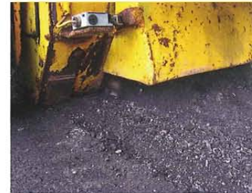
Bild 3: Fräsen der Asphaltdeckschicht inklusive der Bewehrung
