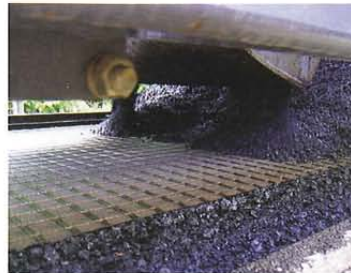
Bild 2: Einbau der Asphaltdeckschicht auf die Asphaltbewehrung
